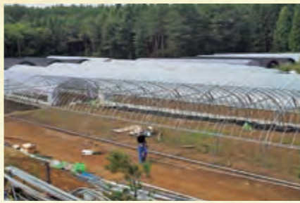
雪害からハウス復旧作業
