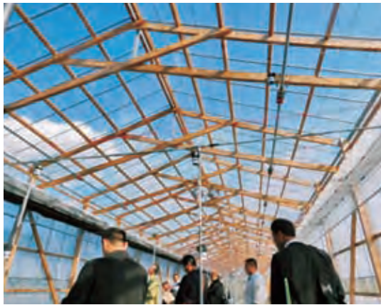
木骨ハウス 耐候性があり、採光性も改善されている
