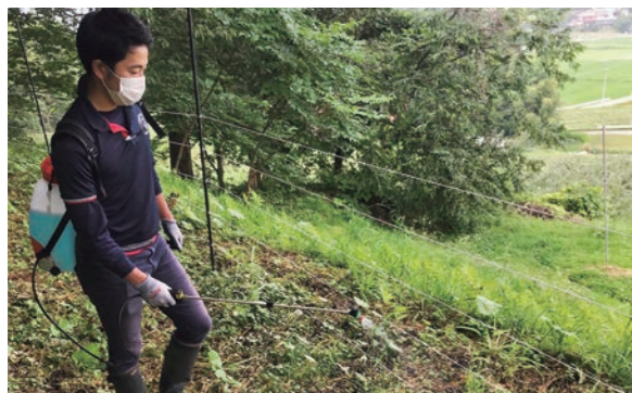
漏電による電圧低下を防ぐため、除草剤で下草を防除
